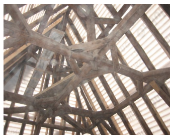
Charpente de l'école
